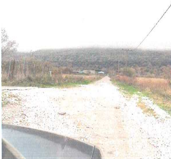
Εικόνα 3- 1: Φωτογραφική αποτύπωση Οδού Σ3.
