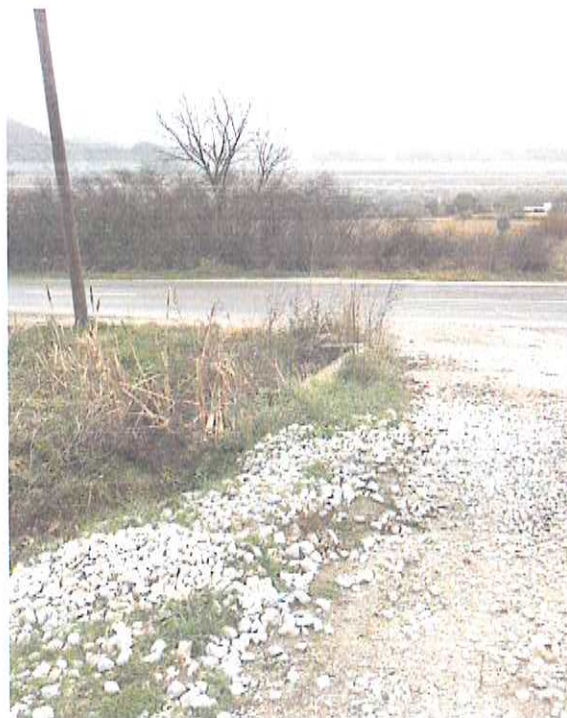
Εικόνα 3- 2: Φωτογραφική αποτύπωση Οδού Σ3 – υφιστάμενο τεχνικό.
