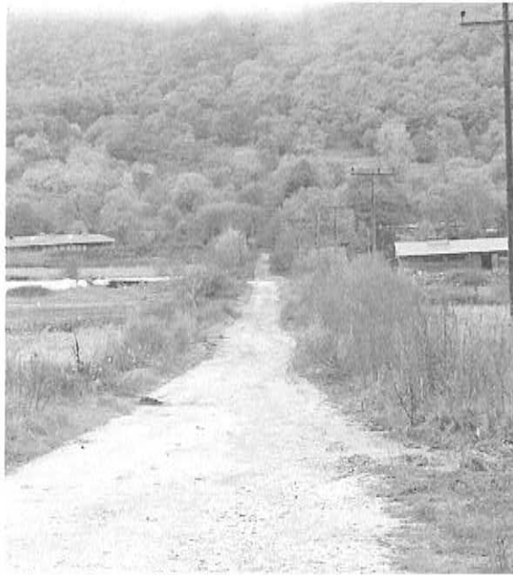
Εικόνα 4- 1: Φωτογραφική αποτύπωση Οδού Σ4.
